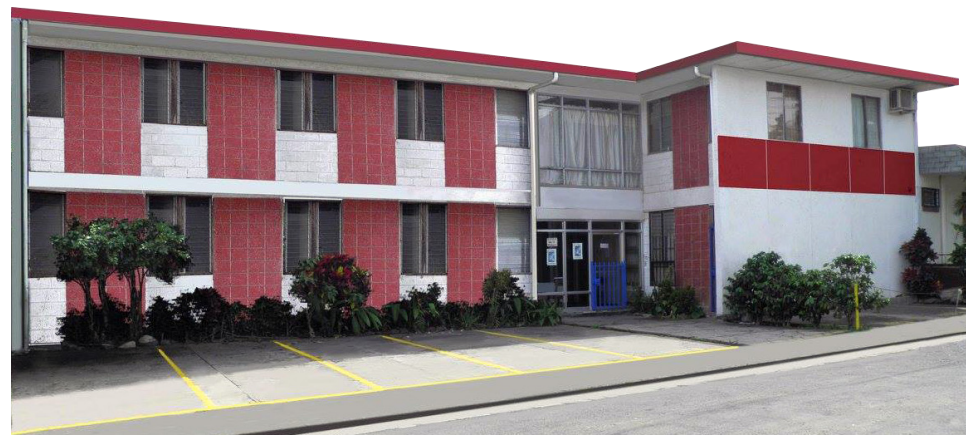
Instalaciones del Instituto Centroamericano de Extensión de la Cultura (ICECU) y de la Fundación Escuela Para Todos de Centroamérica en San Pedro Montes de Oca, San José de Costa Rica.
